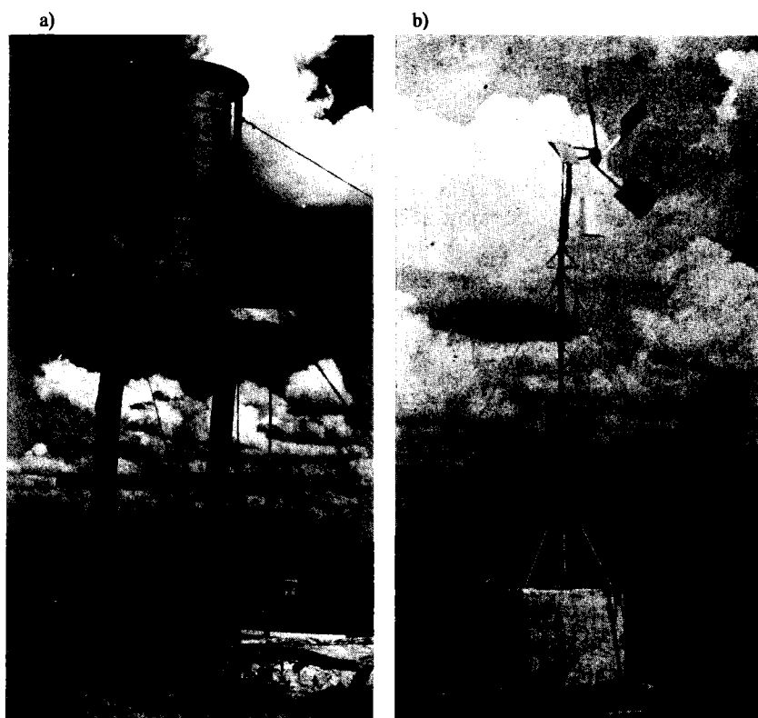
Figura 12. Molinos de viento: a) de canecas, a la izquierda y b) de doble efecto tipo Gaviotas, a la derecha.
