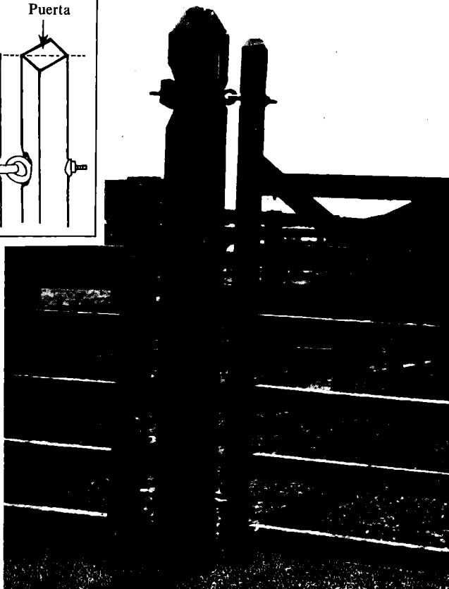
Figura 20. Para permitir que las puertas abran al máximo en los dos sentidos, las aristas del madriño y de la puerta que llevan los goznes deben quedar frente a frente.
