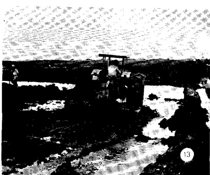
Cuchilla suspendida en los tres puntos del tractor, cortando las partes altas del terreno.
