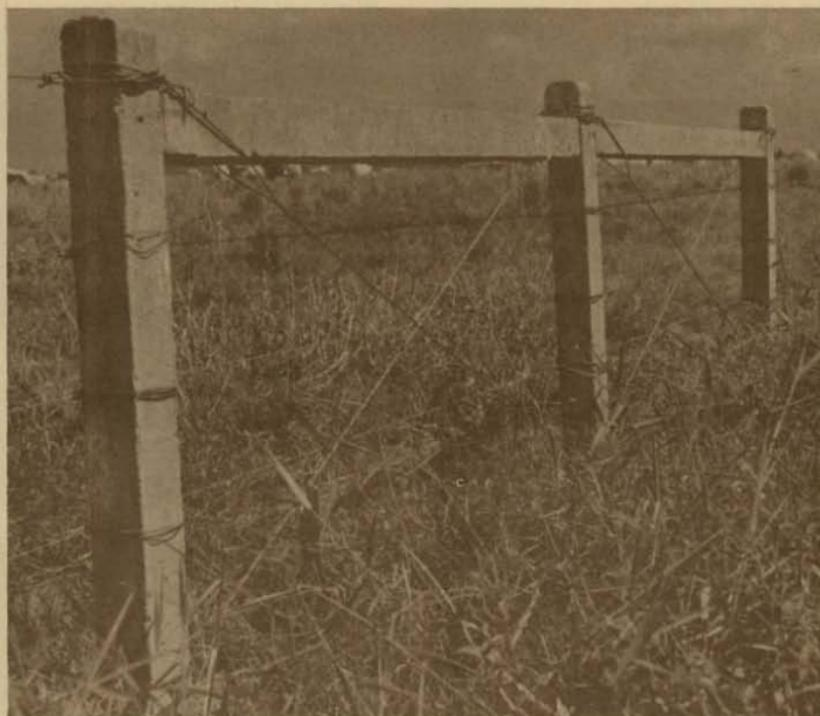
Figura 3. Estructura tensora. Obsérvense en este caso dos alambres templadores formando una X entre cada par de postes.
