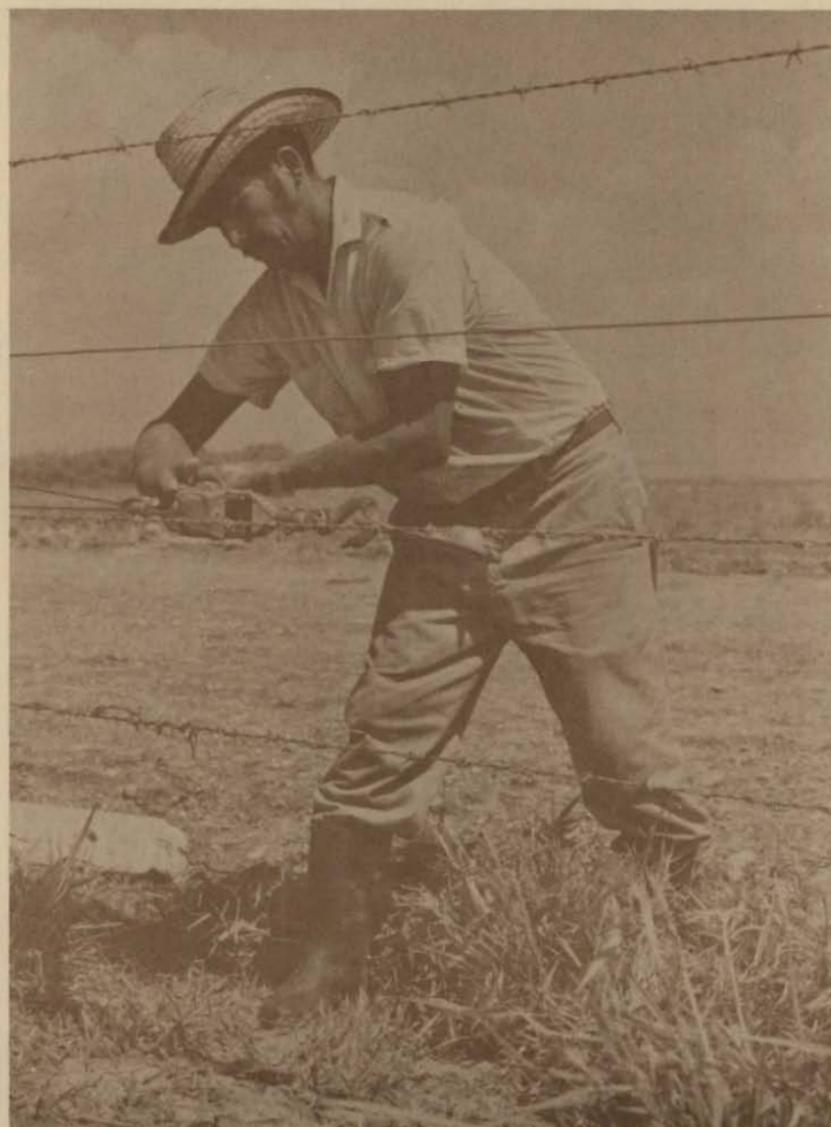
Figura 8. Ajuste de la tensión de los alambres.
