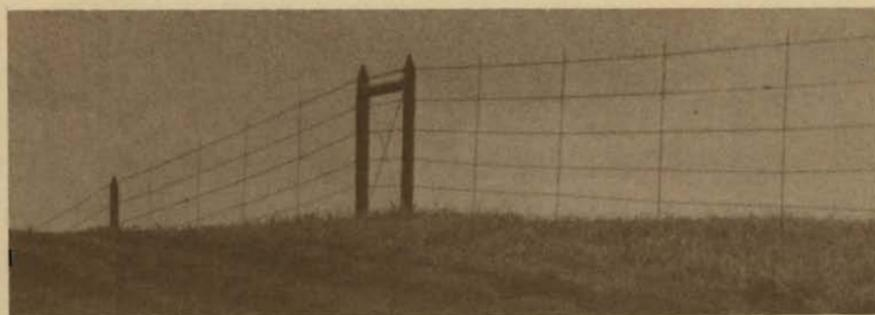
Figura 5. Estructura tensora en una cerca con distancias inferiores a 15 m entre postes intermedios.
