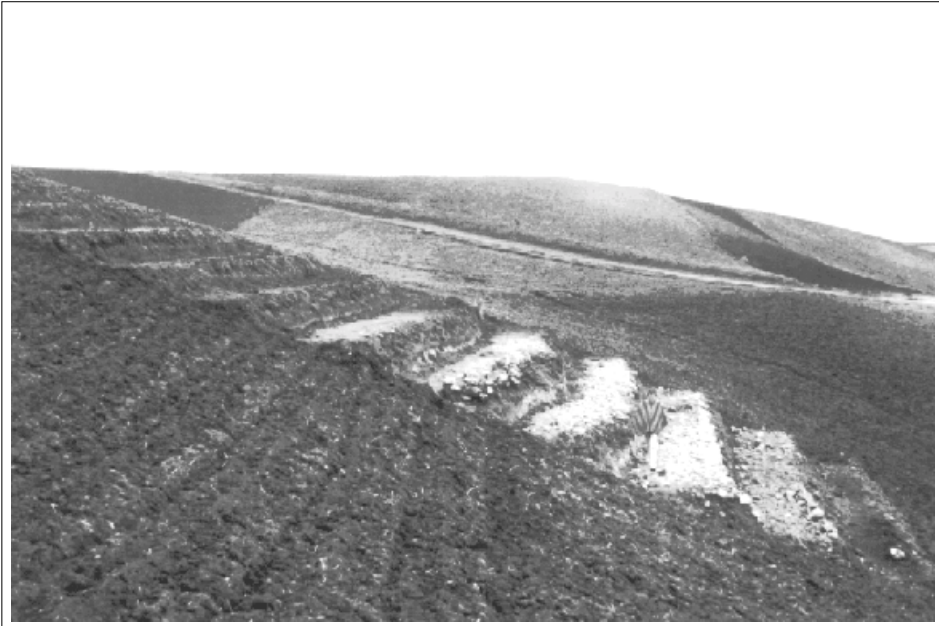
Figura 3. Vista de terrazas muertas o murallas de piedra, construidas con trabajo comunal ( minka ) al norte de Potosí, Bolivia.
