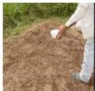
adición de la mezcla
