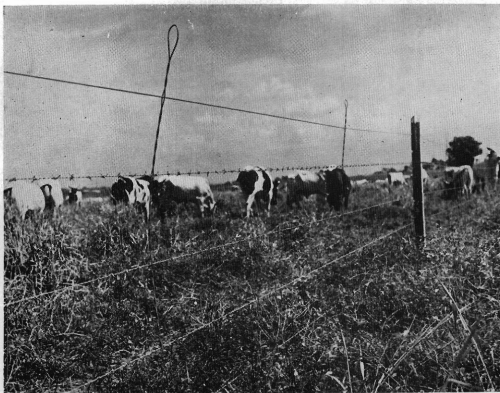
Las cercas que se han instalado en la sede del CIAT utilizan postes separados entre sí a distancias mayores de las que se usan corrientemente.
