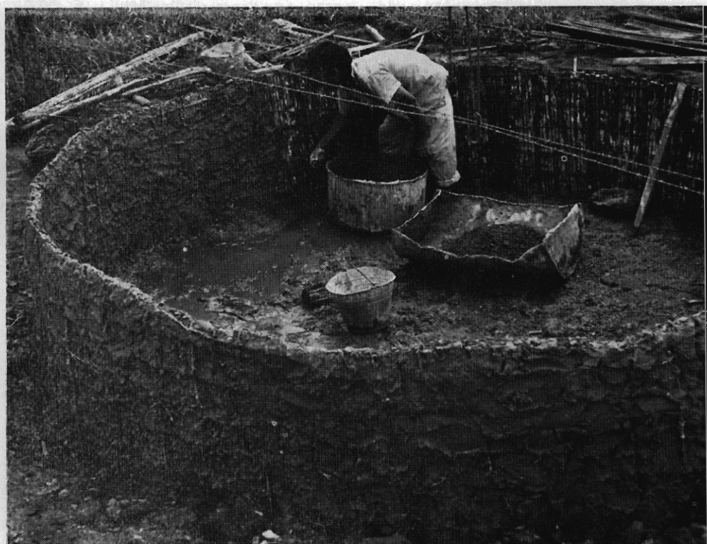
Un tanque rústico para almacenamiento de agua construido con estacas de pa'ma clavadas en el suelo y sujetas con alambre de púa desechado de las cereas viejas. Para construirlo, no es necesario hacer una estructura formativa de madera.
