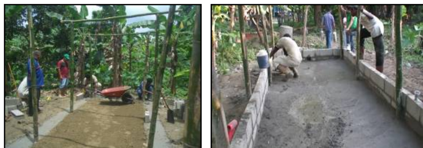
Figura 27. Construcción de jaula para producción de lixiviado
