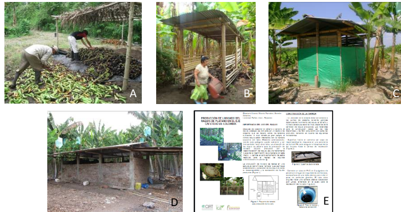
Figura 8. Diferentes diseños de ramadas: A: Piso en plástico, B: Piso en plástico sobre madera, C: Piso en concreto con pendiente, D: Estructura semi industrial en concreto y E: Folleto protocolo para producción de lixiviados
