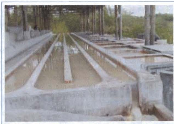
Figura 2.5. Tanques y canales de sedimentación de almidón.
