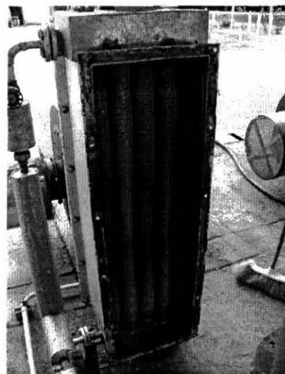
Fig. 33. Intercambiador de calor
