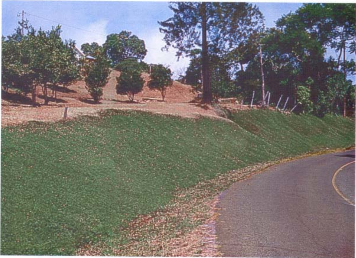
Figura 8. Utilización de A. pintoi cv. Porvenir para controlar erosión del suelo en taludes de una vía pública.
