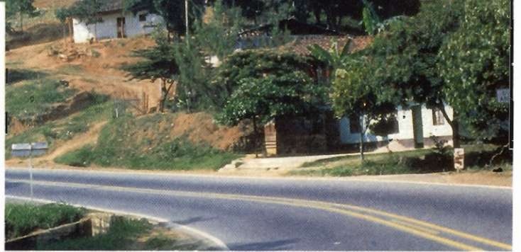
Una ladera en Mondomo, Colombia, donde se aprecian las etapas iniciales de erosión. La deforestación y los sistemas inadecuados de cultivo la aceleran.
