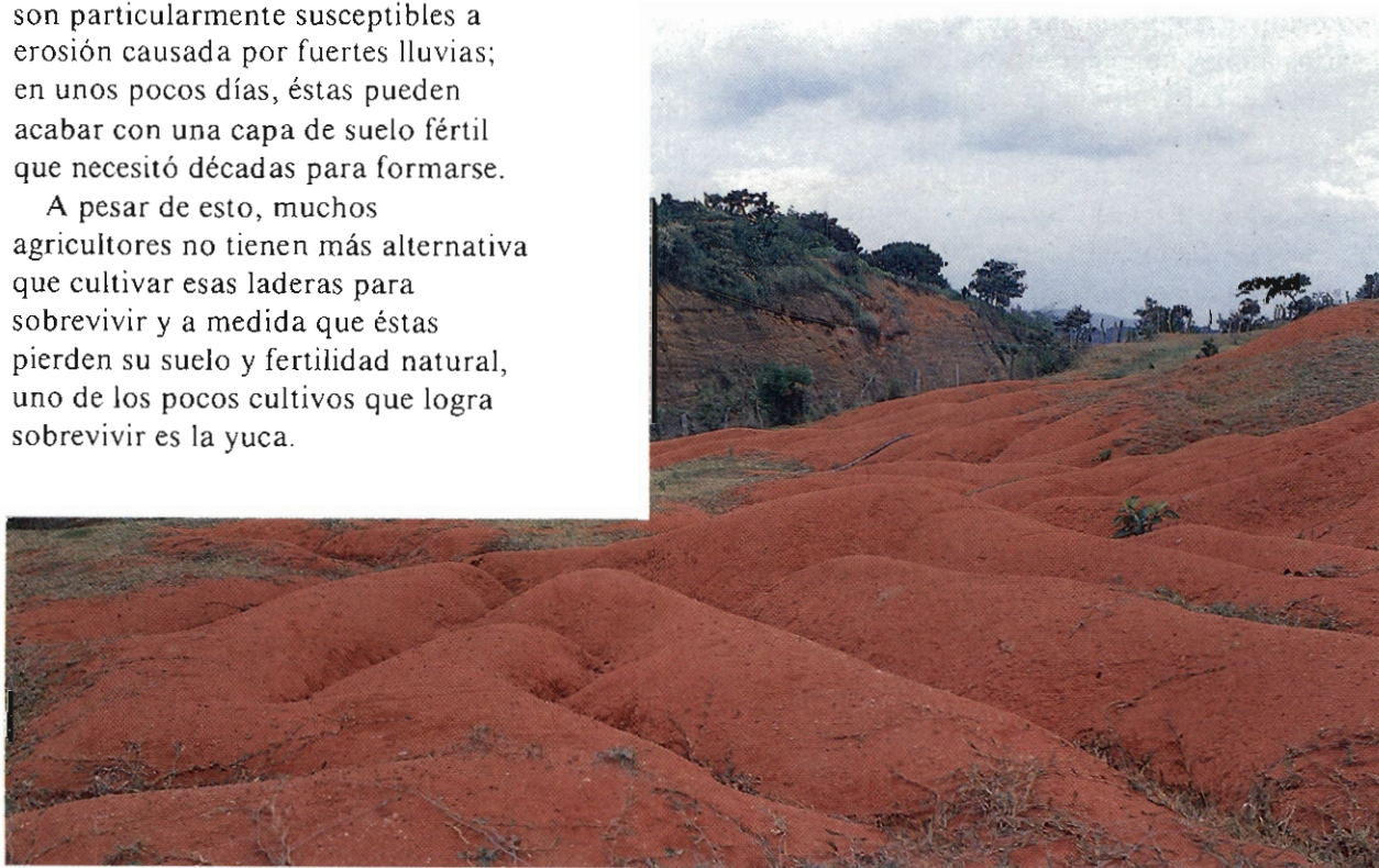
Cuando los suelos han sido perturbados por la tala de la vegetación natural o por sistemas inapropiados de cultivo, las fuertes lluvias y el lavado pueden causar erosión severa.
