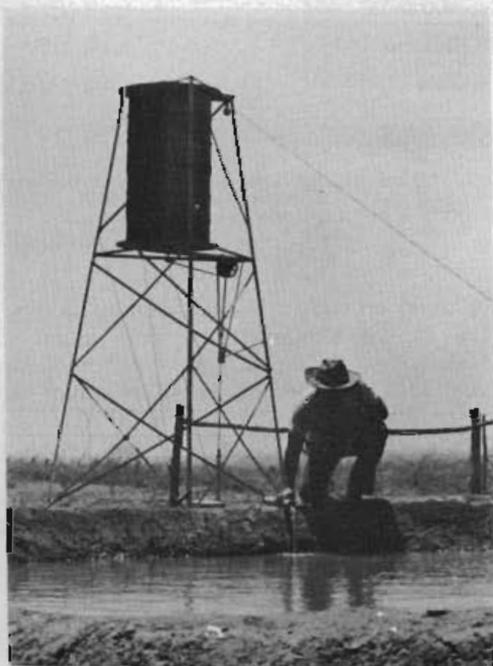
Molino de viento instalado en Carimagua, montado en una torre de acero galvanizado en ángulo, de 5.5 metros de altura. En el estanco que aparece en primer plano se aprovecha la tierra excavada al hacer el pozo. (Fotografía: J. Spain)
