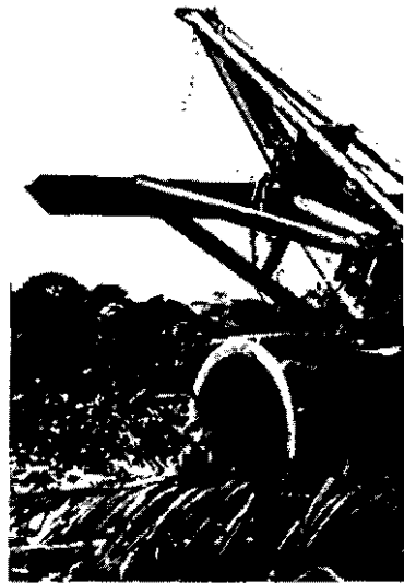
Figura 5. Triturador de árboles en el proceso de desmonte.
