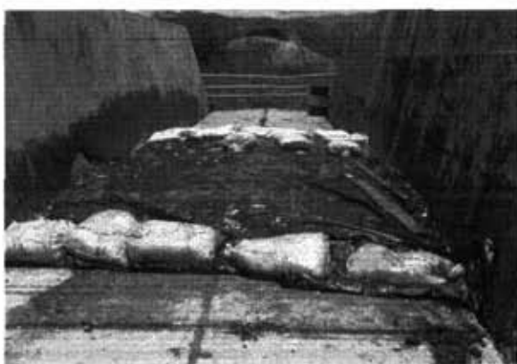
Silo tipo bunker
