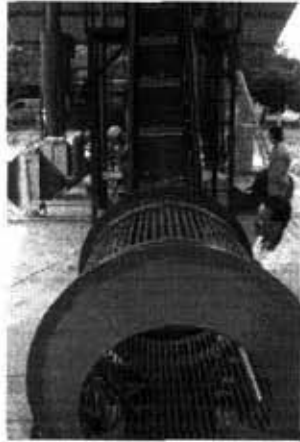
Figura 6.3.2. Limpieza de raíces.
